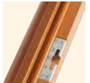
Gâche de sécurité intégrée et affleurante
